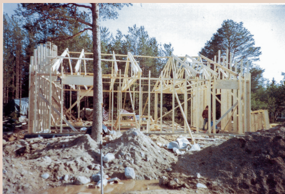
Stommen byggdes av husfabriken, därefter utfördes bygget på eget ansvar.
